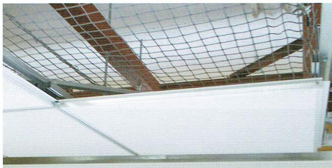
天井裏に落下防護ネットを設置することにより、天井裏からの落下物を受け止め、天井の崩壊を防ぎます。老朽化した屋根下地や、工場など天井裏にダクト等、天井裏に想定落下物がある場合に有効です。
